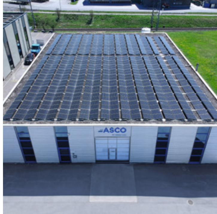
Auf dem Dach der ASCO-Produktionsstätte in Eschlikon, Schweiz, wurden 2022 insgesamt 336 Solarmodule installiert.
